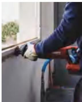
Tronçonnage des appuis pour faciliter la dépose.
