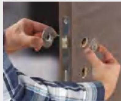
Placer les rosaces de béquilles en insérant les piliers traversant dans les perçages prévus d'usine.
