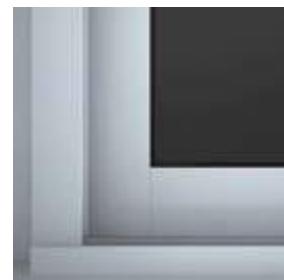
Détail ext. : partie inférieure drainage caché
