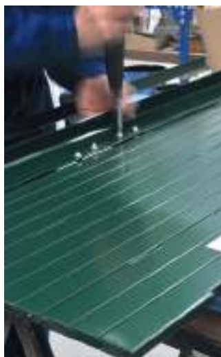
PRÉMONTAGE EN ATELIER des tapées cornières et accessoires
