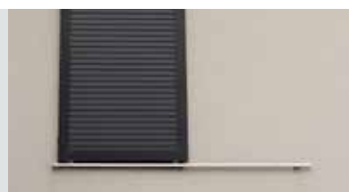
POSE SUR RAIL FILANT
